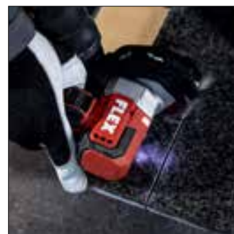
... vrubování dlaždic a přímé odsávání vzniklého prachu...
